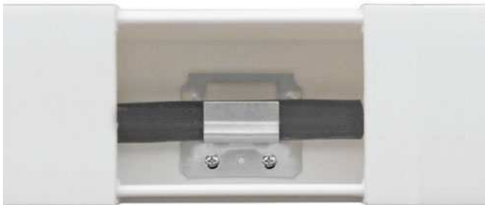
Рисунок 13 - Монтаж кабеля в кабельном канале с помощью крепления Кляймер
