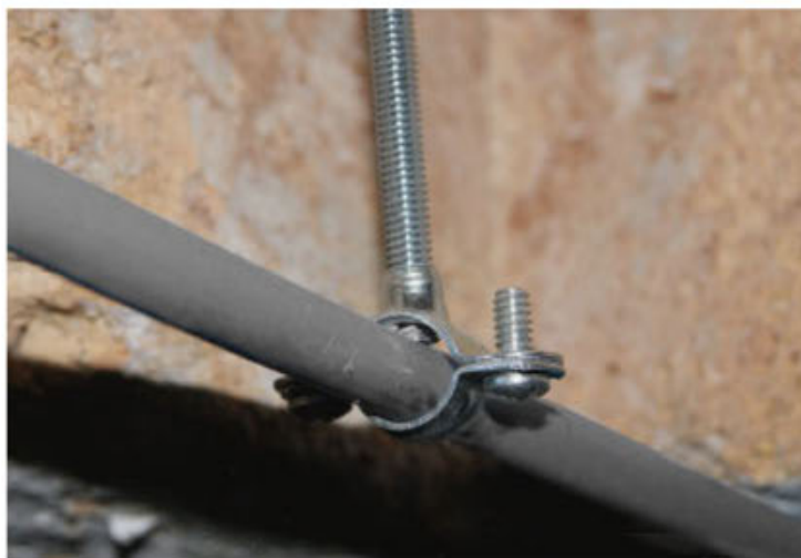
Рисунок 14 - Прокладка ОКЛ на подвесах к потолку
